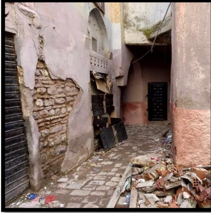
الصورة 15: سقوط التلييس الخارجي (عن الباحثين).
