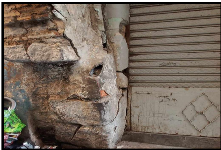
الصورة 13: تشكل طبقة الباتينا سوداء اللون على الواجهات الخارجية للمباني (عن الباحثين).
